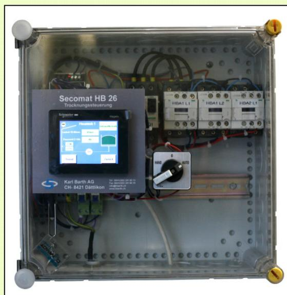
Le système de commande de séchage HB26 est un système automatique basé sur la CPC avec une interface utilisateur graphique tactile. Il est équipé d'une sonde combinée d'humidité et de température, d'une combinaison de protection intégrée et d'un disjoncteur de moteur.
